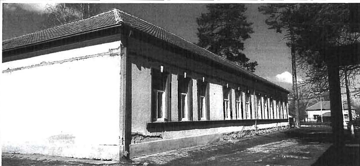
Фотографије фасада објекта бр. 1 – стара школа
