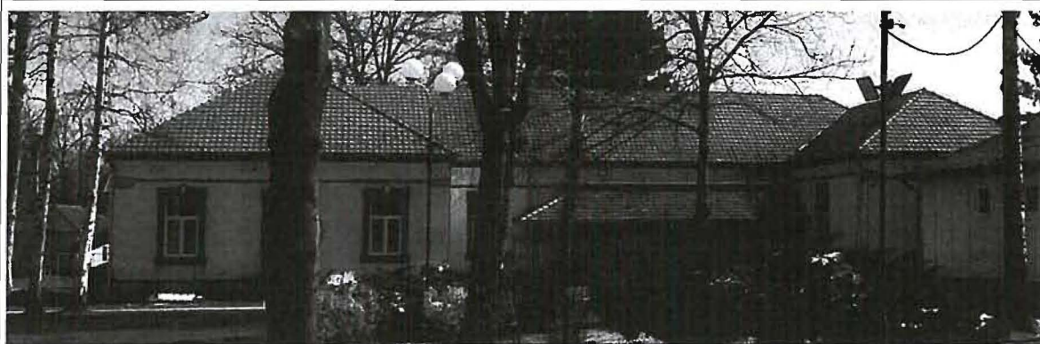
Фотографије фасада објекта бр. 1 – стара школа
